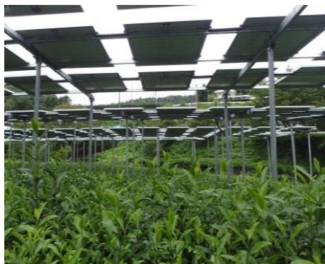
設置された太陽光パネル
