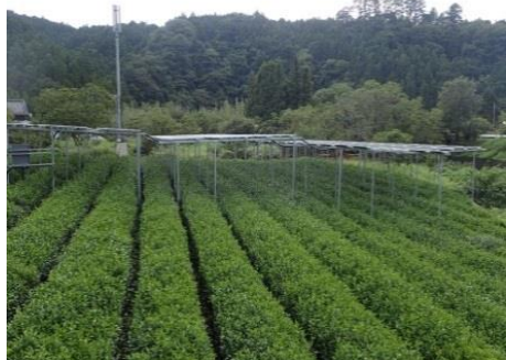
発電施設の外観
