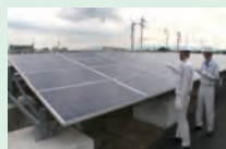
太陽光発電設備の検査の様子
