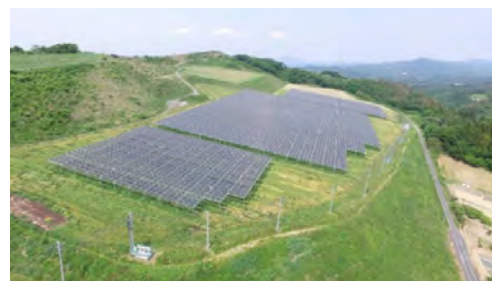
発電設備の外観（吉高地区）
