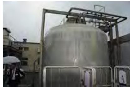
発酵槽（タンク）…駐車場に設置可能な小型装置
