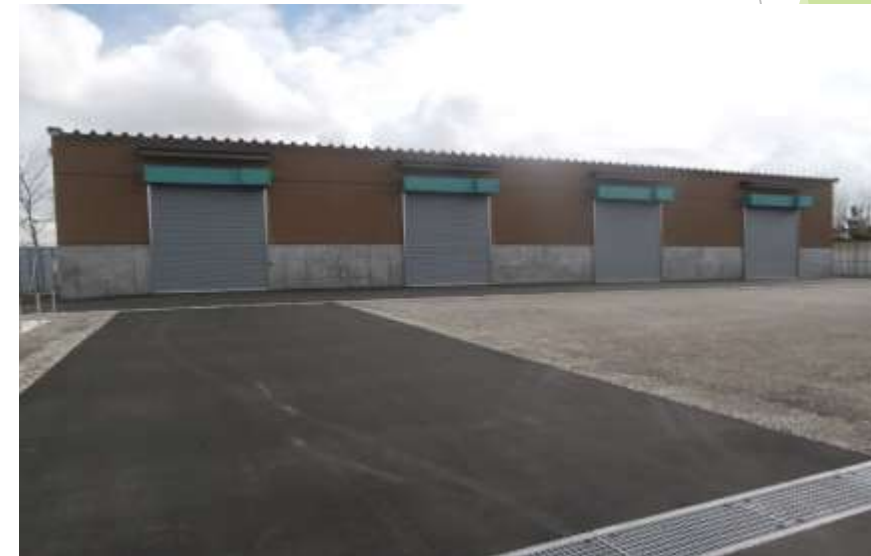
10 利用農家の要望に応じて、堆肥ストック棟を建築を進めています。平成30年4月末完成
