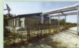
ロックワール製臭機(容積600m³)全貌
