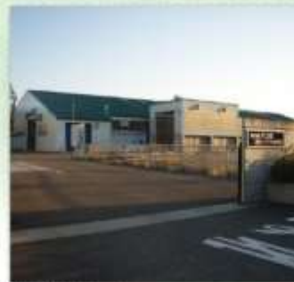
リサイクルセンター 全貌
