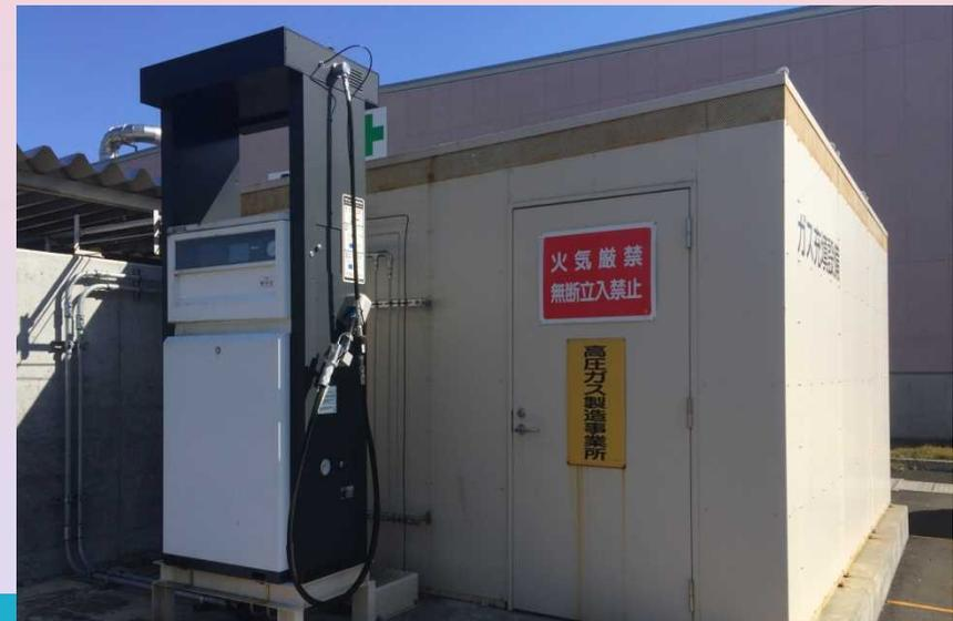
メタンガスを圧縮し液化して燃料とします。最大で4t車7台分の給油能力があります。
