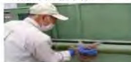
(洗浄消毒作業)
