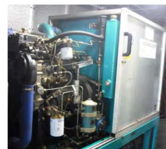
バイオガス・BDF混焼発電機
