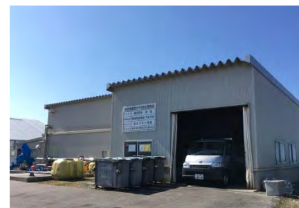
バイオマスプラント全景
