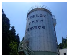
メタン発酵槽
