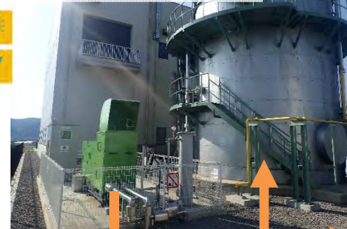
ガス発電設備の余熱はメタン発酵槽の加温や消化汚泥の乾燥に活用
