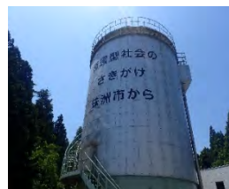
メタン発酵槽
