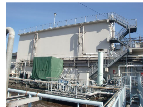
嫌気反応槽 (UASB)
