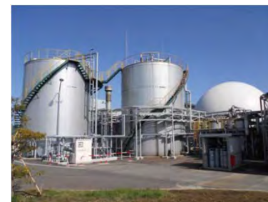
メタン発酵槽・ガスホルダー
