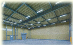
大規模流通に対応した保管施設
