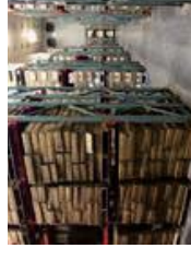
保冷库の改修
