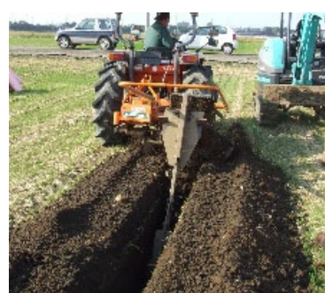
暗渠排水の整備
