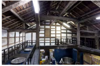
大きな梁がめぐらされた仕込みタンクが並ぶ酒蔵の内部。
