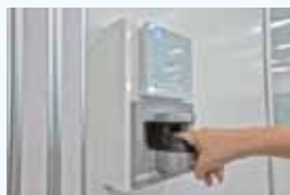
ID認証装置、生体 認証装置による入 退館管理
