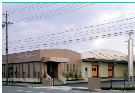
大垣工場 外観
