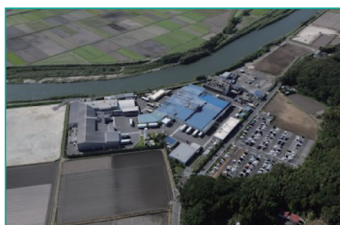
有明ミート工場全景
