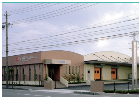
大垣工場 外観
