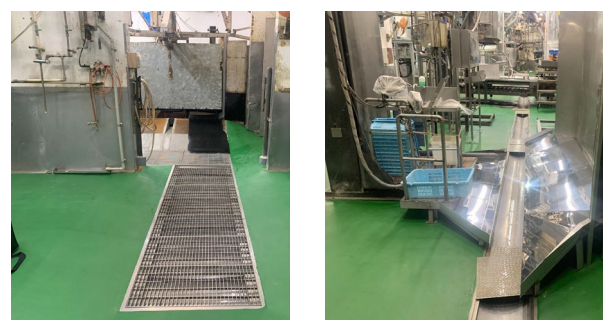
床塗装(改修) 残渣シューター設置
