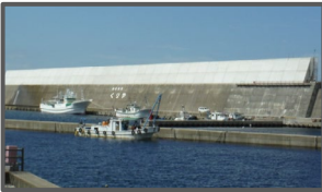
防波堤の嵩上げによる越波対策
