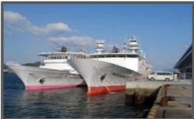
漁船の大型化に対応した岸壁の整備
