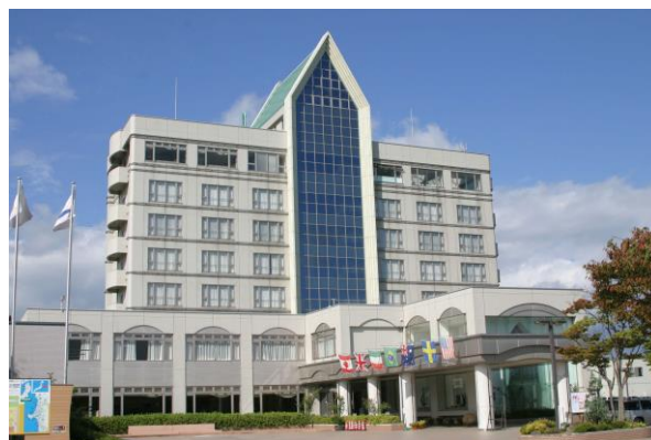
【ホテルサンルーラル大潟 外観】
