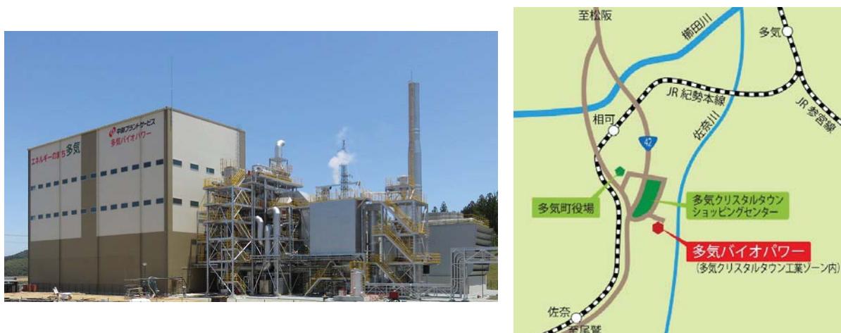
図 29 木質バイオマス発電所（多気バイオパワー）の外観図（左）と概略地図（右）
