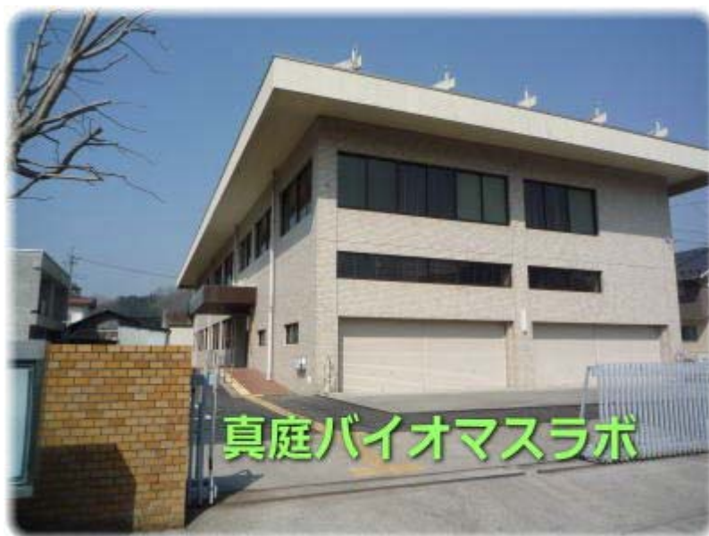
図2.1-4 真庭バイオマスラボ外観
