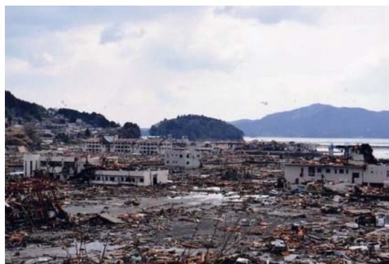
〔平成23年3月12日 志津川地区中心部〕
