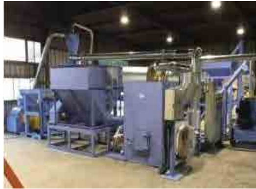
図表4-5 既存のペレット製造工場
