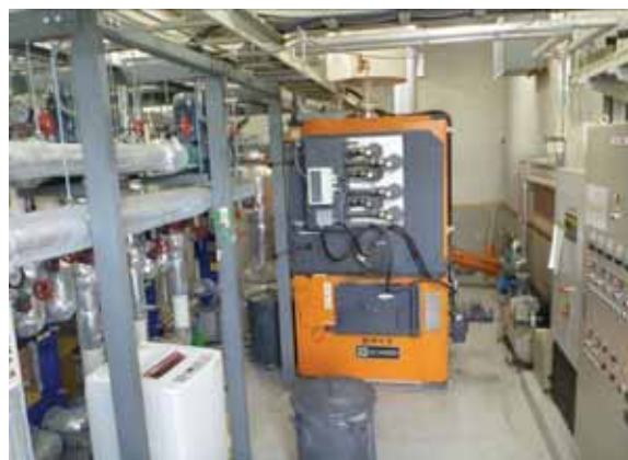
写真 2.1.5 「たきのうえドリームホテル溪谷」バイオマスボイラー設備
