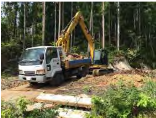
木材搬出試験の様子
