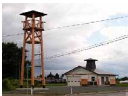
消防屯所(H13)
