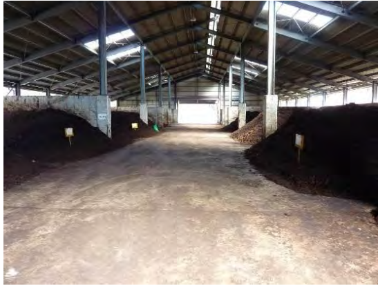
畜産農家 堆肥化設備
