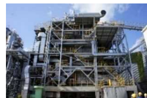
木質バイオマス発電所（朝来市）
