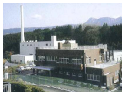
小山町衛生センター
