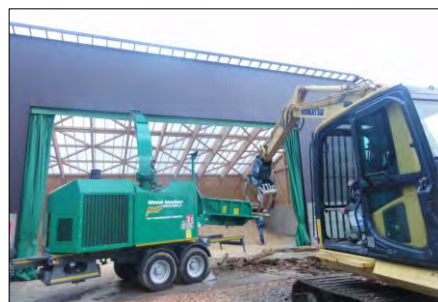
写真 2.3.3 木質チップ燃料製造施設
