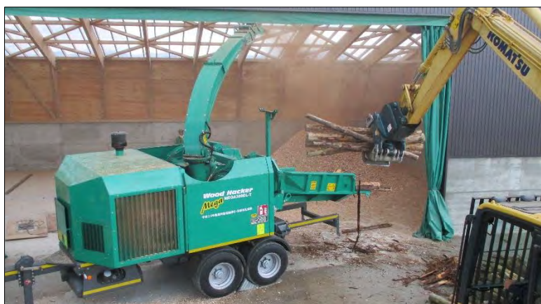
写真 1.6.3 木質チップ燃料製造施設
