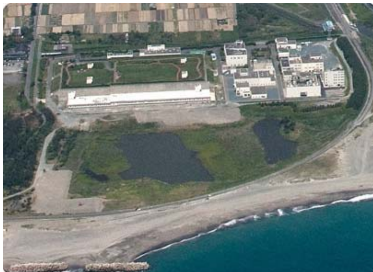
西遠浄化センター
