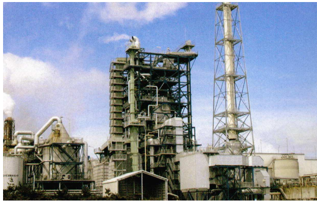
リサイクル発電設備
