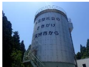
メタン発酵槽
