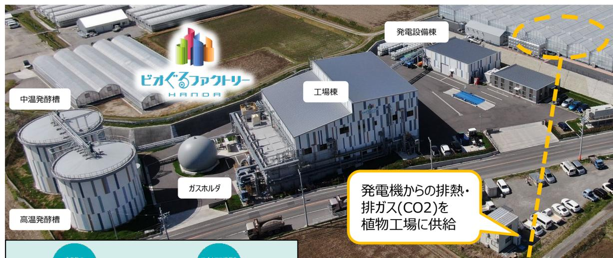
発電機からの排熱・排ガス(CO2)を植物工場に供給
