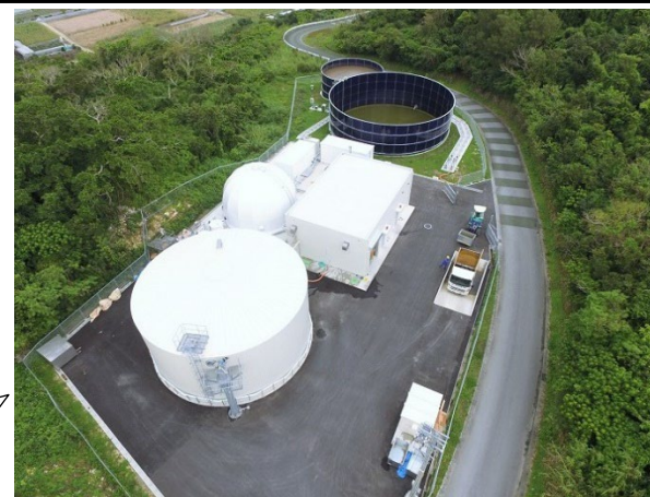
八重瀬町バイオガスプラント
