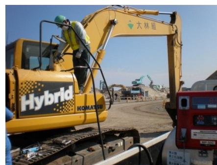
<写真：震災復旧現場での 建設機械利用>
