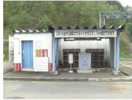
写真 4-13 場内ガスステーション
