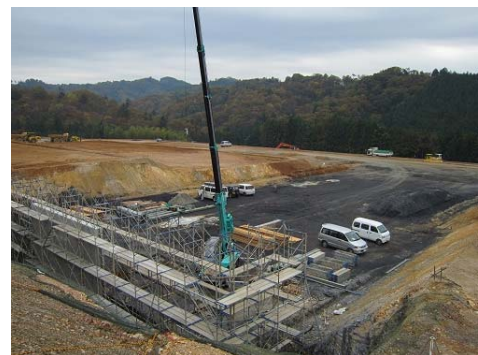
図 62 工場立地場所の造成の様子
