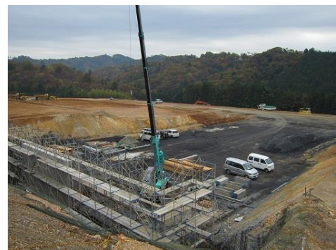
図 62 工場立地場所の造成の様子
