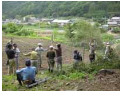
侵入防止柵 の設置
