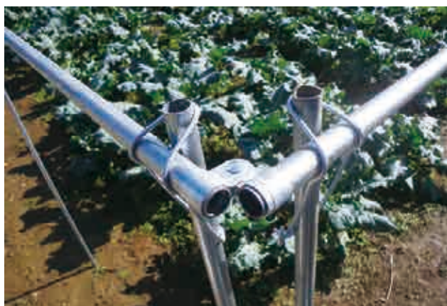
角部をジョイント資材で結合
