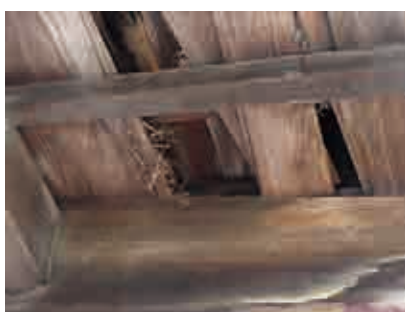
天井裏への侵入口
