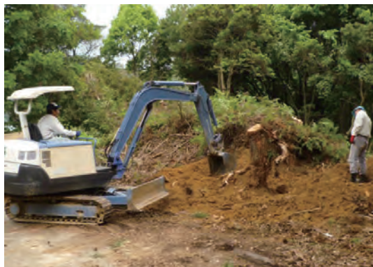
設置場所の造成
