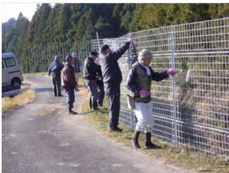
4.1Kmの防護柵を設置。総事業費は約1200万円、その一割が地元負担
