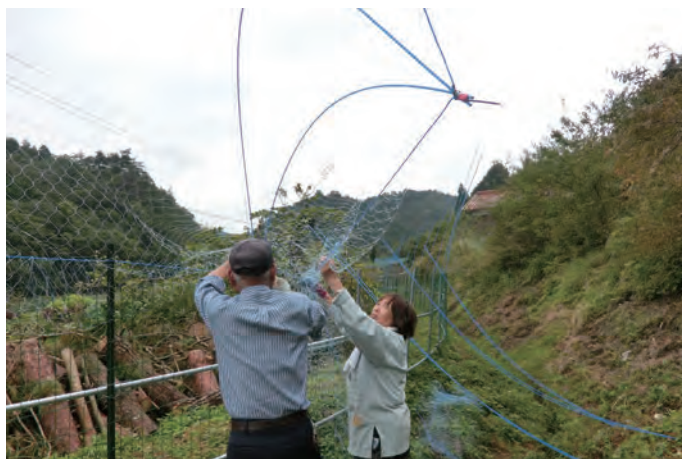
支柱がしなるので脚立なしに設置が可能
