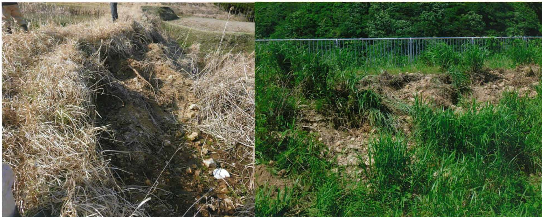
ため池法面 掘起し
