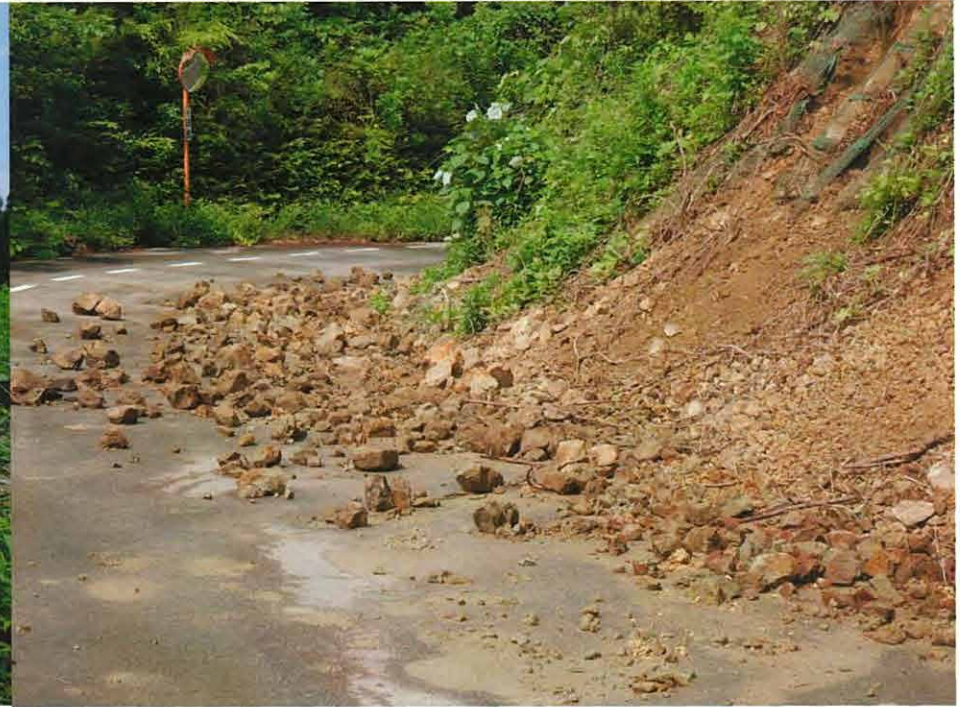
道路法面 掘起し
