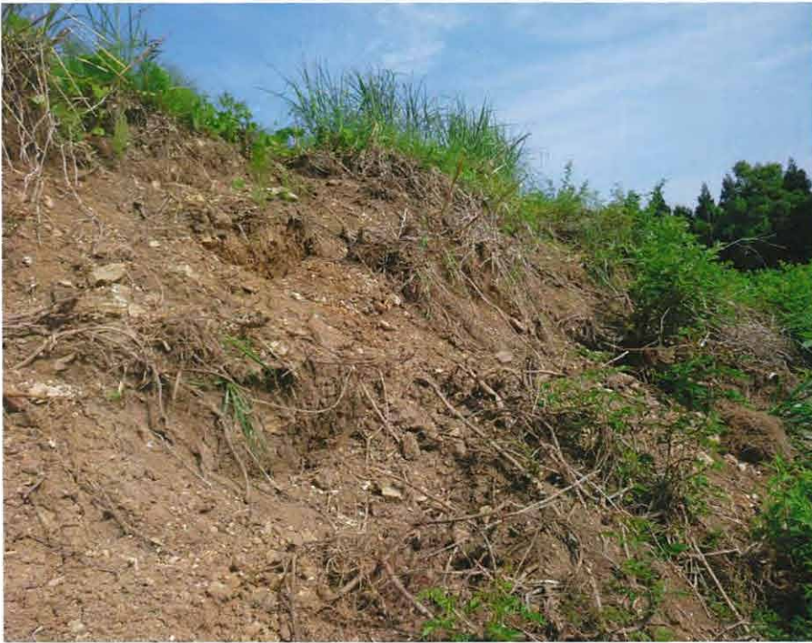
耕作放棄田法面 掘起し
