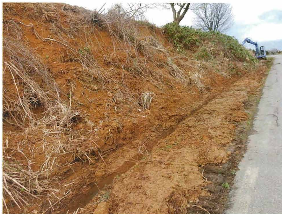
道路法面掘起し
