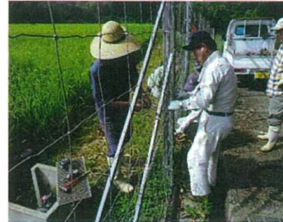
防護柵の補修
