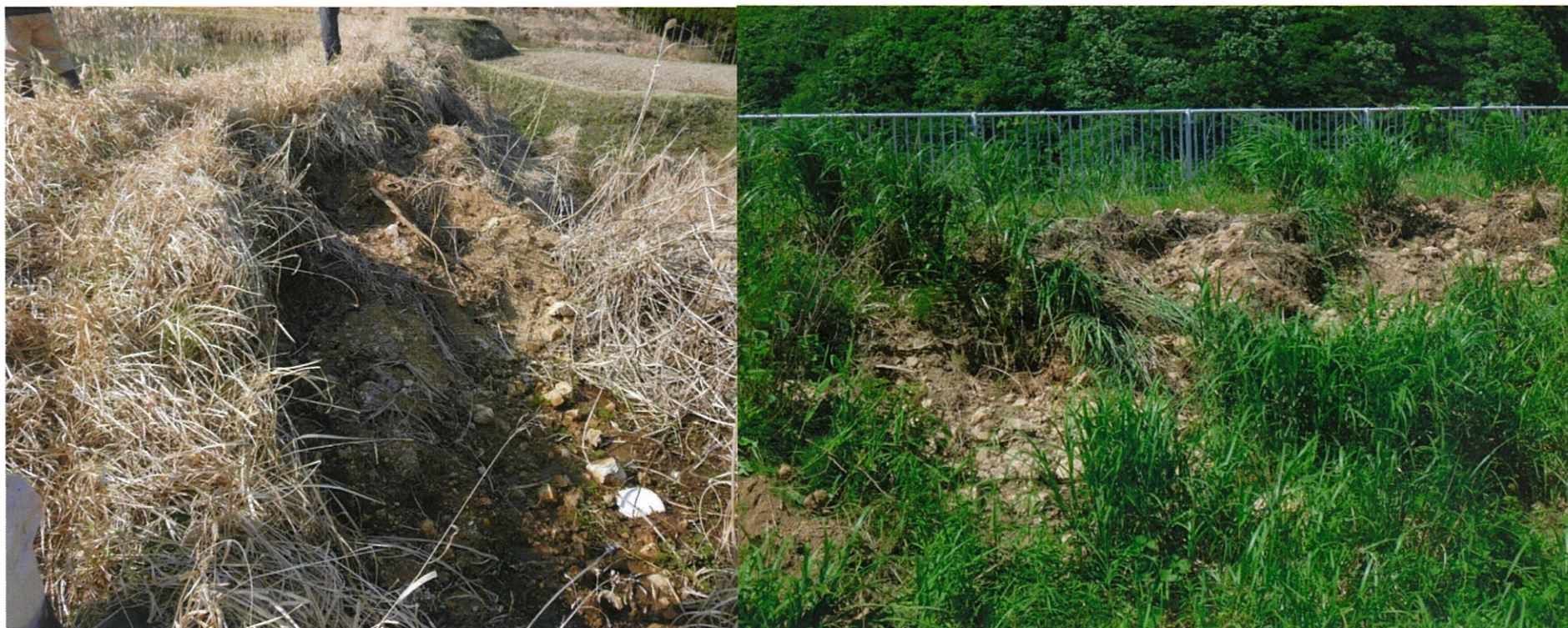
ため池法面 掘起し
