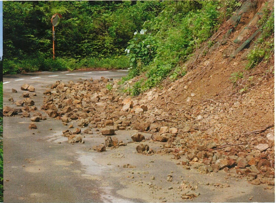
道路法面 掘起し
