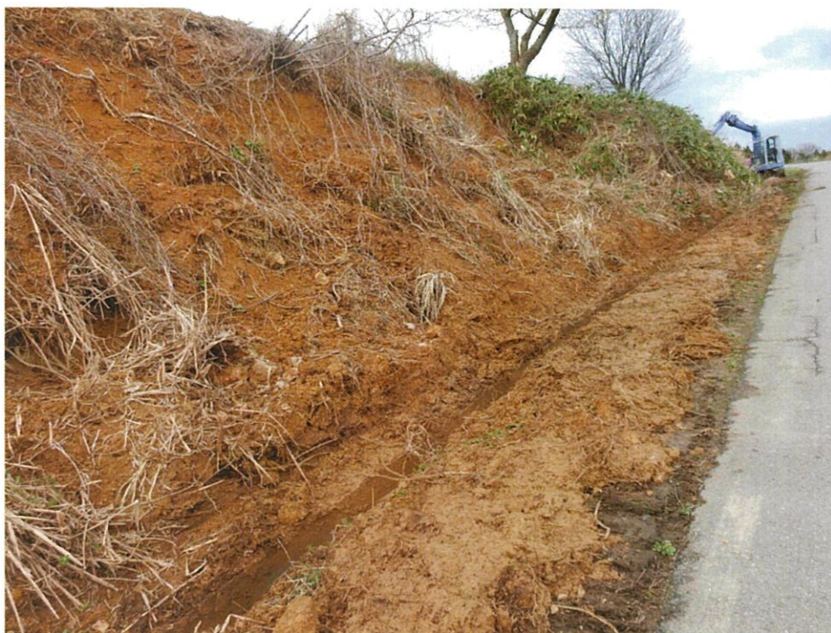
道路法面掘起し
