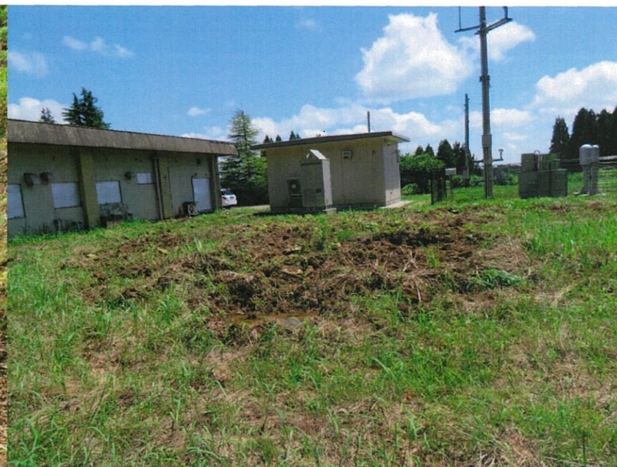
旧 一般廃棄物処理施設敷地内
