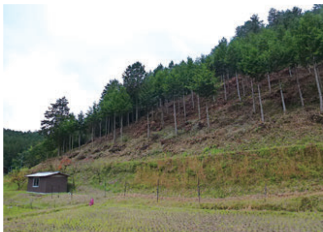
写真3-2-2 緩衝帯により柵周辺の潜み場を除去する
