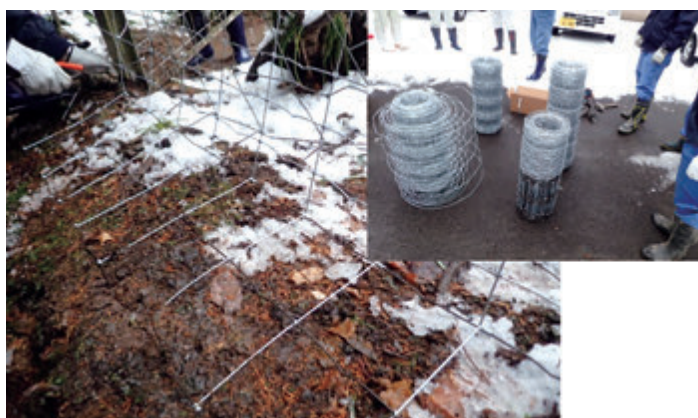
写真3-1-4 金属柵の下部に侵入防止の裾を敷設する
