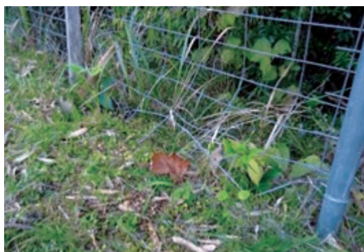
写真2-2-2 管理が不十分な侵入防止柵の例
