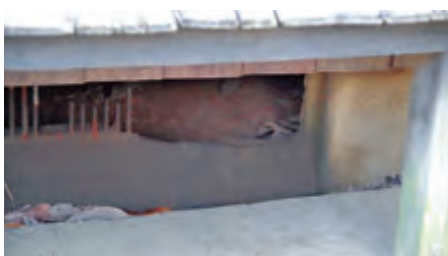
写真2 頻繁に利用されている神社の床下侵入口
