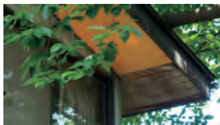
写真6 家屋の軒を板で修復
