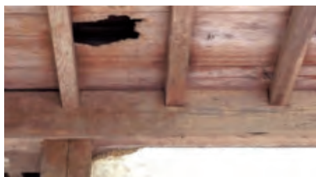
写真4 小さな穴を破行為により広げて侵入場所として利用
