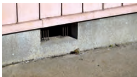
写真1 床下通風口からの侵入が最も多い
