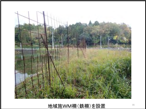
地域施WM柵(鉄柵)を設置
